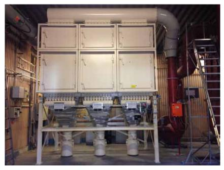
führung für max. 180 °C . Die Filtermedien des Schlauchfilters sind aus einer Nomex-Nadelfilz-Qualität und haben eine zusätzliche Säureschutzausrüstung.
