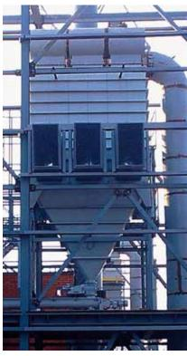
licherweise eine ATEX Zone 20 ausgewiesen, da der abgereinigte Kohlenstaub ständig in einem explosionsfähigen Staub-Luft-Gemisch vorliegt. Für die Reingasseite und den Außenbereich wurde die ATEX Zone 22 ausgewiesen. Als Explosionsschutzkonzept wurde konstruktiver Explosionsschutz festgelegt, d. h. alle Aggregate in druckstoßfester Bauweise mit Druckentlastung über Berstscheiben. Die zusätzlich erforderliche explosionstechnische Entkopplung verhindert das Ausbreiten einer möglichen Explosion.
