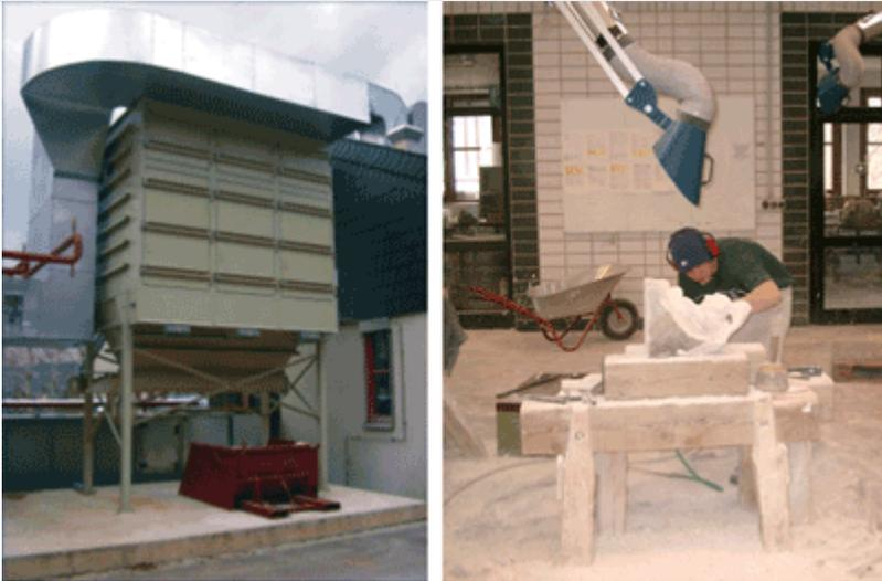
[Translate to russisch:] In einem Ausbildungsbetrieb für Steinmetze werden ca. 20 Arbeitsplätze über einen Zentralfilter entstaubt. Die Luftmenge beträgt insgesamt 360 m<sup>3</sup>/min. und wird über einen **Lamellenfilter Infa-Lamellen-Jet AJL 3/1083 dsf**, mit 324 m<sup>2</sup> Filterfläche gereinigt.
