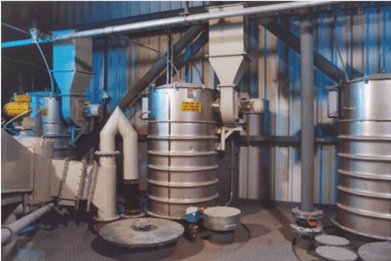
[Translate to russisch:] Für eine Mischanlage in einer Zementfabrik wurden mehrere Silos für Zement, Kalksteinmehl, Flugasche und Hüttensandmehl installiert. Diese Silos werden über Becherwerke mit den Produkten befüllt.
